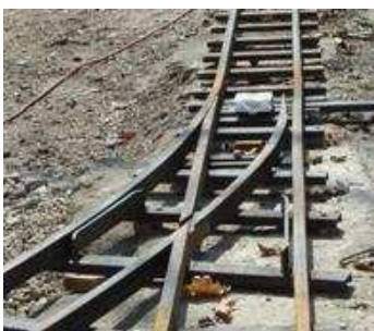
Im Bild die Weiche im Ausfahrtgeleise 1 das auch neu gebaut wird. RS
